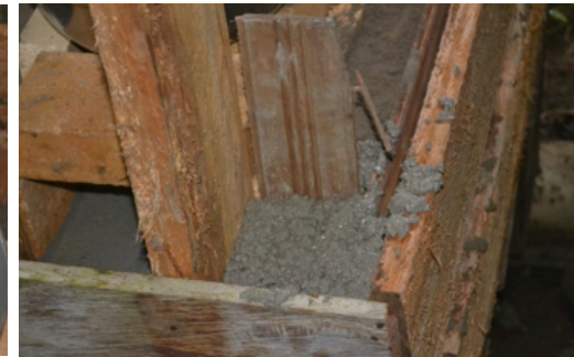
58 Esquina de la formaleta con mezcla
