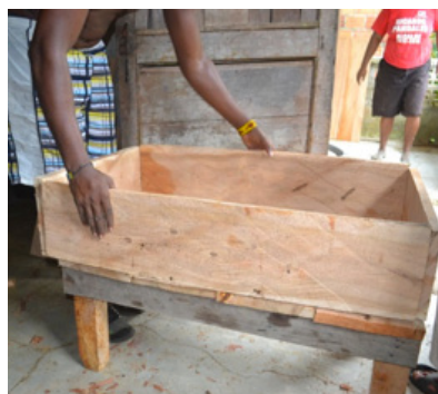
12 Ubicando la formaleta encima del piso de la base del fogón
