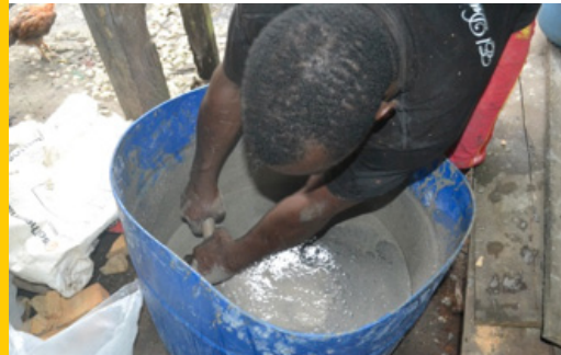
56 Haciendo la mezcla
