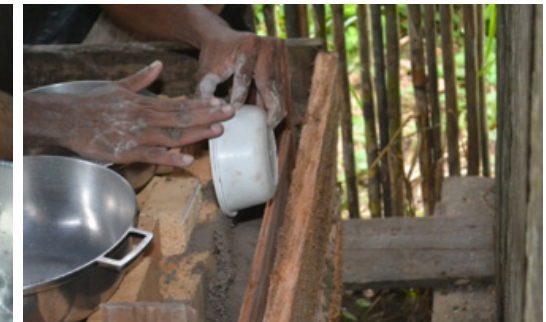
55 Vaceando la ceniza en la formaleta interna
