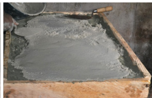
22 Capa de cemento refractario
