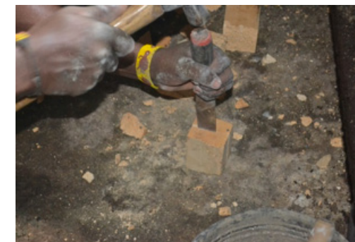
39 Partiendo pedazos de ladrillos para soporte del tubo de desfogue
