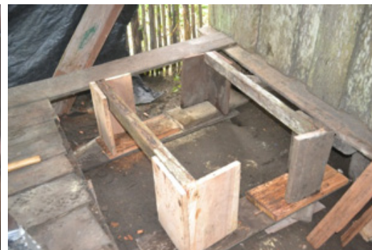
8 Soportes con patas de tablas terminados
