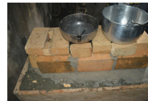
41 Estructura de la cámara de combustión terminada
