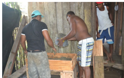
19 Rellenando la cama con cemento
