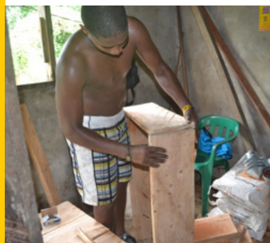
11 Armando la formaleta de la base del fogón
