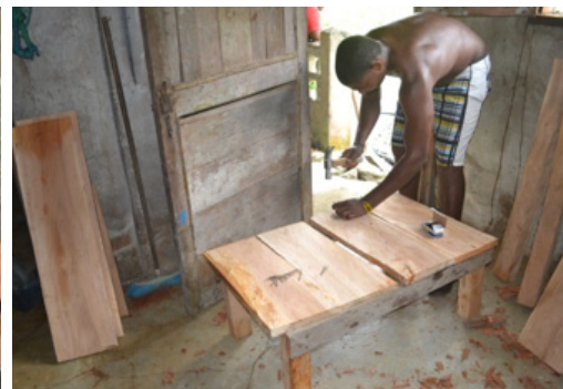
9 Pegando las tablas al soporte de la base del fogón
