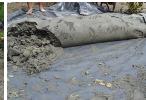
18 Masa formada de barro, arena y cemento después de mover el plástico
