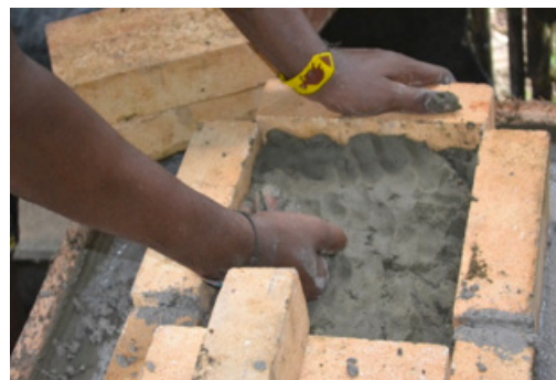
34 Proceso para rellenar el espacio de barrera de la segunda hornilla
