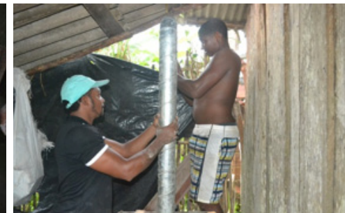
60 Instalando tubo de desfogue
