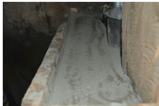
67 Detalle del bloque de cemento refractario
