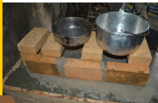
36 Las ollas permiten definir los espacios de las hornillas
