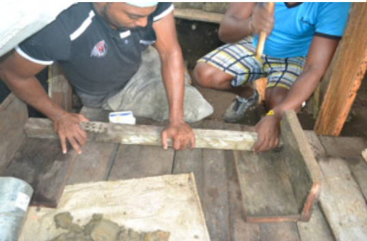
6 Armado de soporte con patas de tabla
