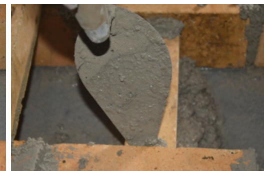
33 Pegado con cemento refractario del ladrillo de barrera de la segunda hornilla
