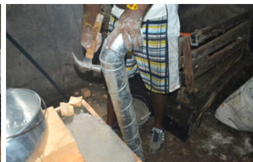
45 Instalando los codos obtenida
