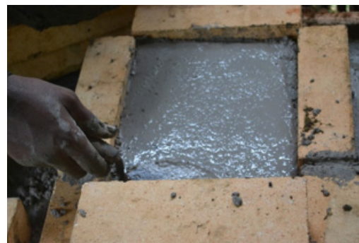
35 Capa de cemento refractario que cubre la capa de arena, barro o ceniza vertida anteriormente
