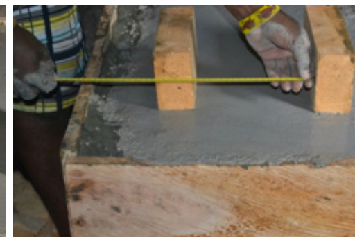
24 Medida de la entrada de la cámara de combustión, veintiún (21) centímetros
