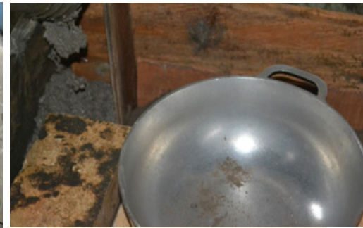
57 Vaciando la mezcla en las esquinas de la formaleta
