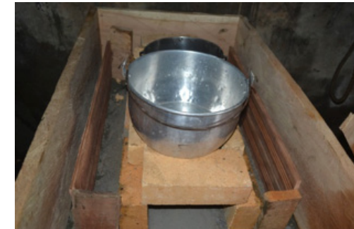
52 Formaletas internas y externas instaladas
