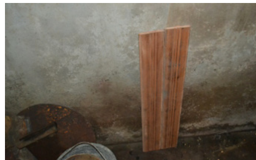
50 Machimbre para formaleta interna
