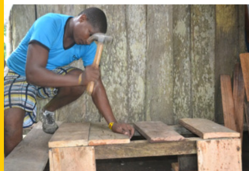
10 Pegando las tablas al soporte de la base del fogón
