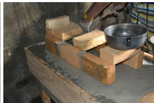
29 Pegando los ladrillos con la mezcla
