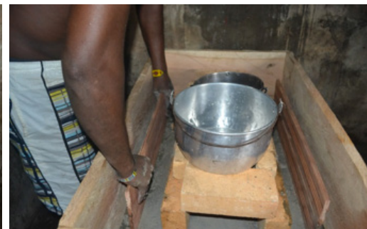
51 Ubicando formaleta interna
