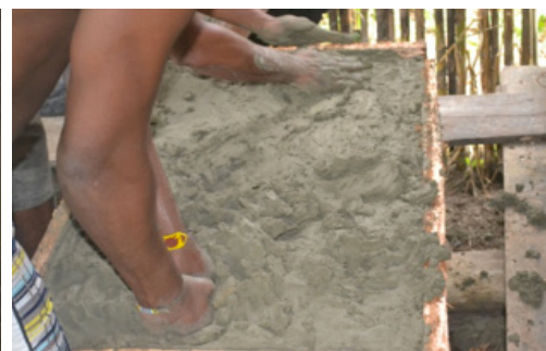
20 Compactando la mezcla con las manos
