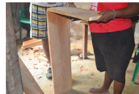
46 Armado formaleta externa
