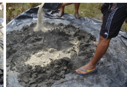
16 Agregando el cemento gris a la mezcla
