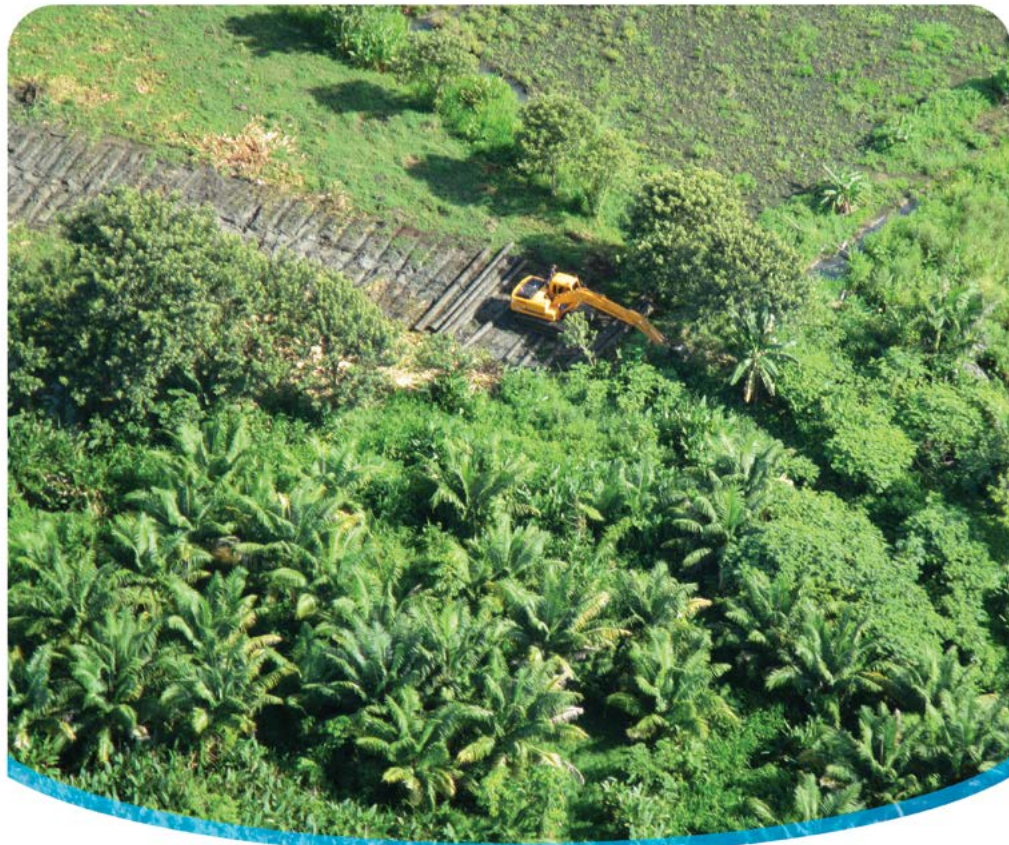
Fotografía 10. Inicio de la construcción de un canal de dragado en zona de yolillales y pantanos herbáceos.
